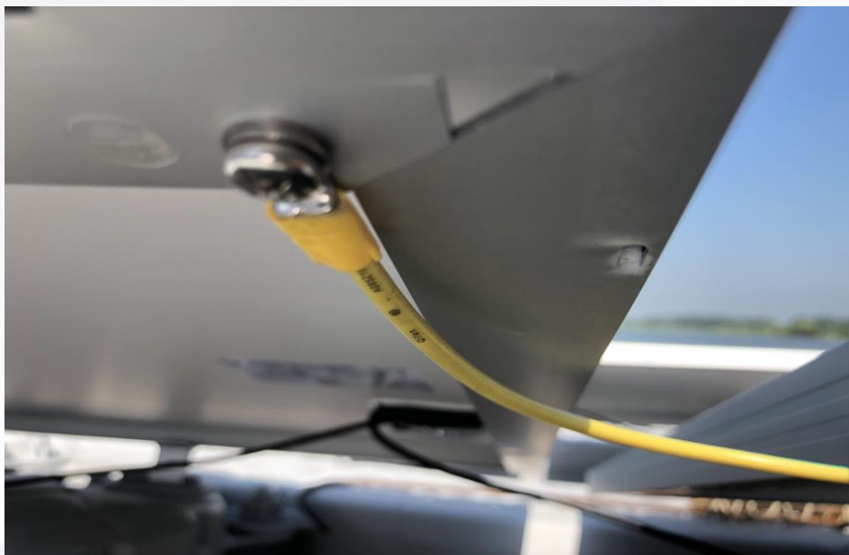
组件接地线连接情况检查
